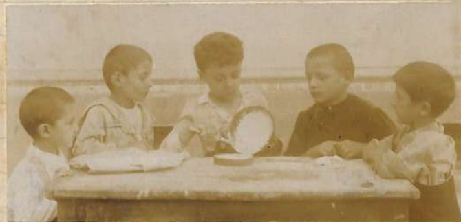
Colatura dello stucco.
